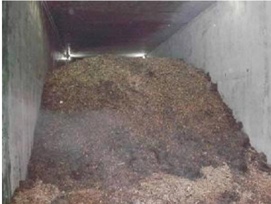
Photo-6 Compostage en piles statiques aérées dans un tunnel en béton fermé © Scott Gamble
