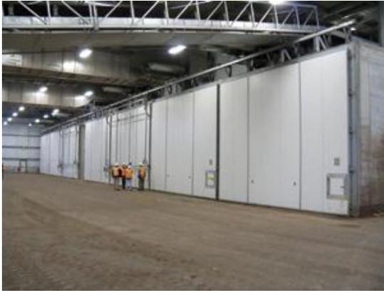
Photo-5 Système de compostage en système fermé (tunnel) © CH2M HILL
